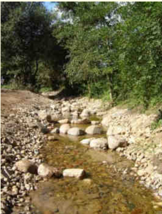
Die neue Sohlgleite - Priesterbach
