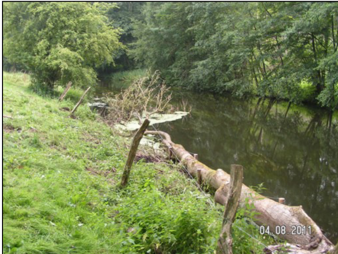
Abb. 19 Umlagerung eines Sturzbaumes im Rahmen der Unterhaltung der Trave
