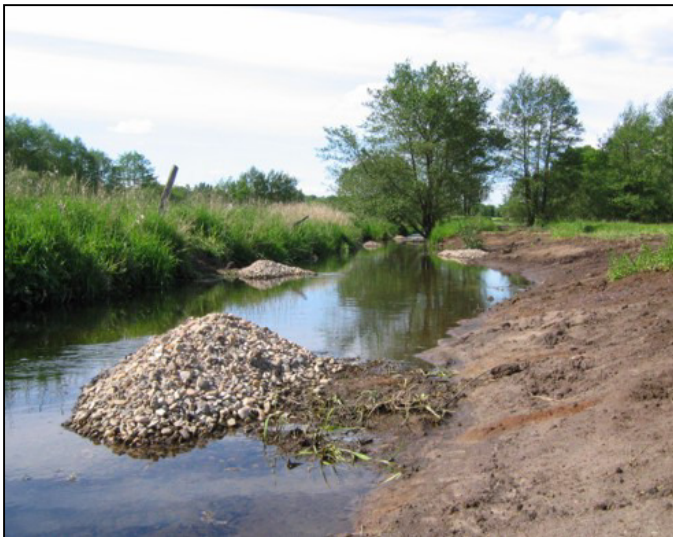
Abb. 21 Einbringen von Kiesdepots an der Steinau im Rahmen von strukturverbessernden Maßnahmen
