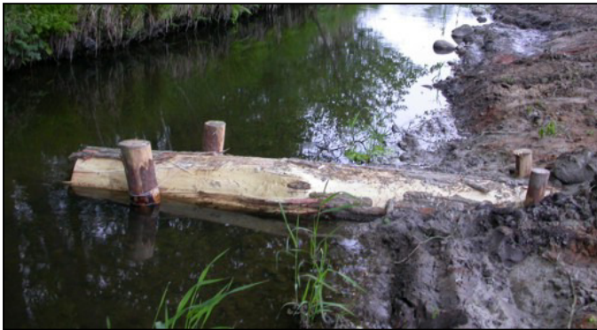
Abb. 20 Einbau von Totholz an der Steinau im Rahmen von strukturverbessernden Maßnahmen
