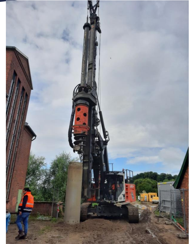
Bild 6: Abschnitt 2, Vorbohren der Spundwandtrasse
