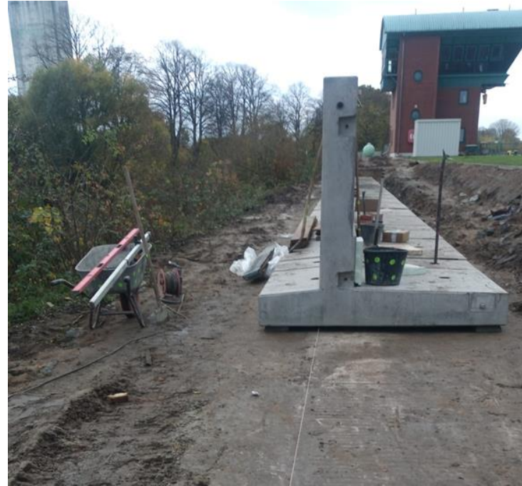
Bild 5: Betonwinkelstützen auf Sauberkeitsschicht
