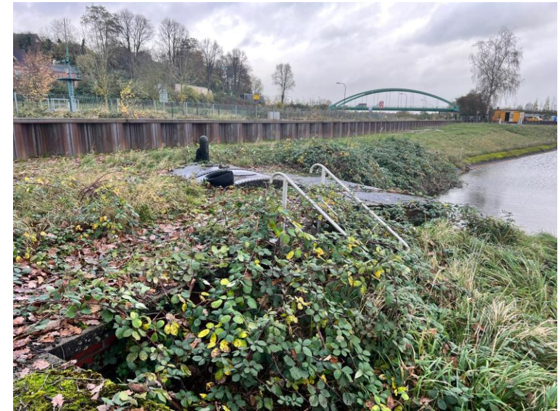
Bild 3: Abschnitt 3, Spundwand entlang der Bahnlinie Lüneburg – Büchen . Oberkante Spundwand = 11,0 m NHN
