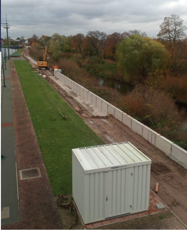
Bild 4: Blick auf Abschnitt 4, Betonwinkelstützen im Bereich des Schleusengeländes
