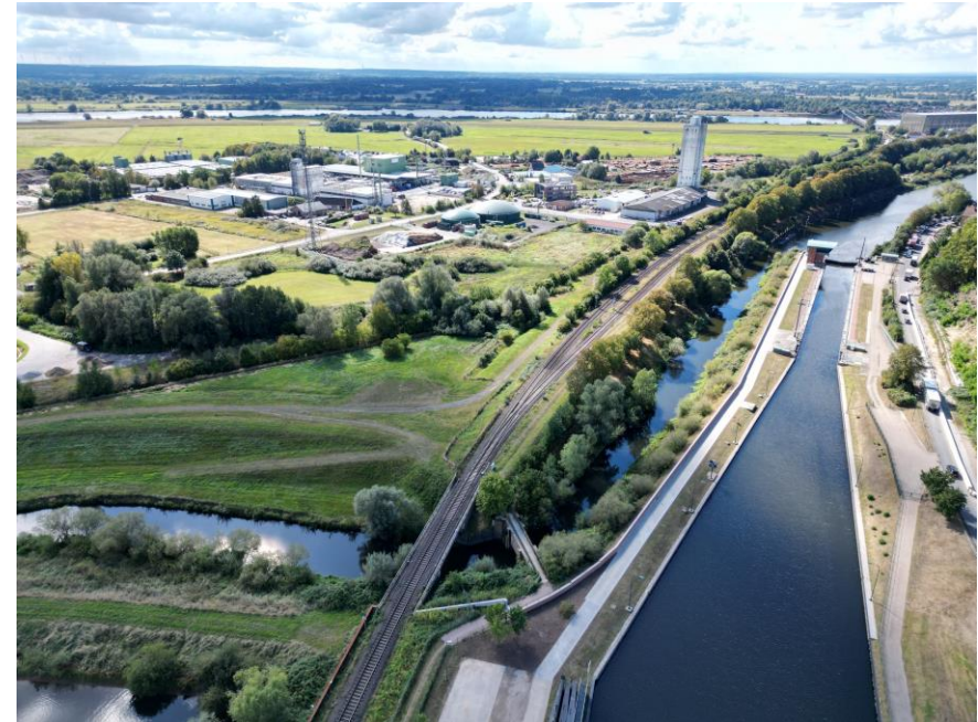
Bild 2: Blick in Richtung Schleuse ELK, Winkelstützwand entlang des Betriebsweges
