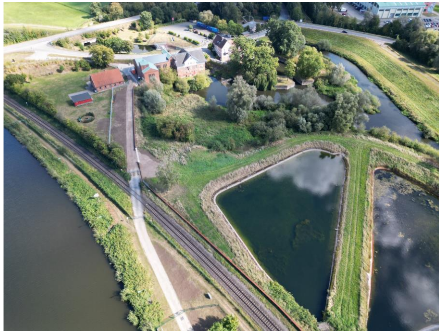
Bild 1: Blick in Richtung E-Werk/Palmschleuse, Stahlspundwand entlang des Bahndammes
