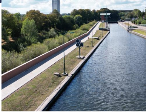
Winkelstützen im Bereich Schleusengelände
