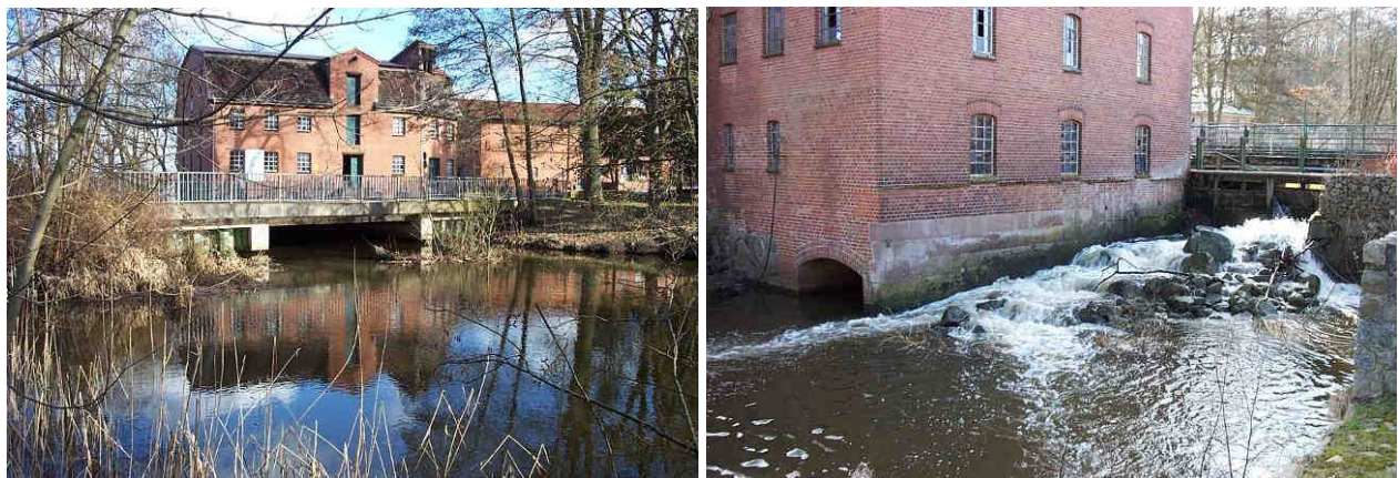
Bild 2: links: Landesstraßenbrücke, rechts: Wehranlage und Sohlabsturz vor der Maßnahmenumsetzung
