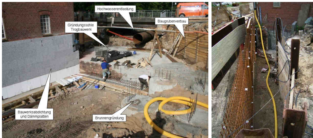
Bild 9: links: Baugrube Trogbauwerk, rechts: Herstellung Trogwände mit Strukturschalung
