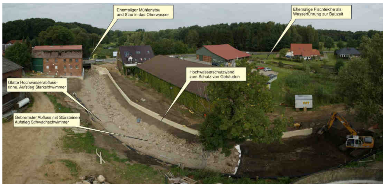
Bild 11: Panoramabild zur Baustelle, links: zweigeteilte Baugrube, rechts: wird noch gebaut
