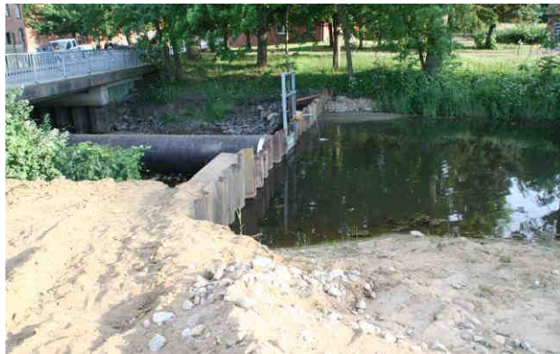
Bild 8: links: Abspernung Oberwasser, rechts: Bachumleitung
