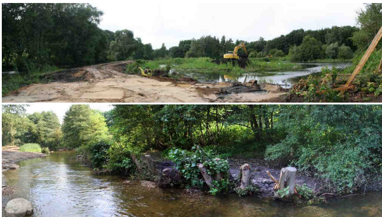
Bild 7: oben: Dammrückbau, unten: Gewässerprofilierung, Strukturverbesserung mit Störsteinen und Stubben
